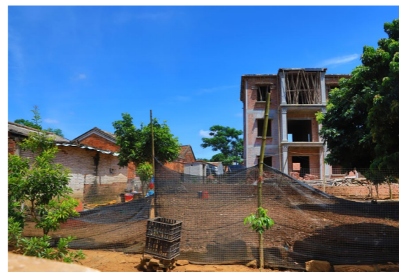
村内在建民居
